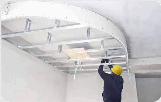
Suministro e Instalación del sistema Drywall
