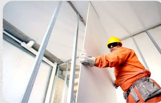
Tabiquerías con planchas de fibra cemento
